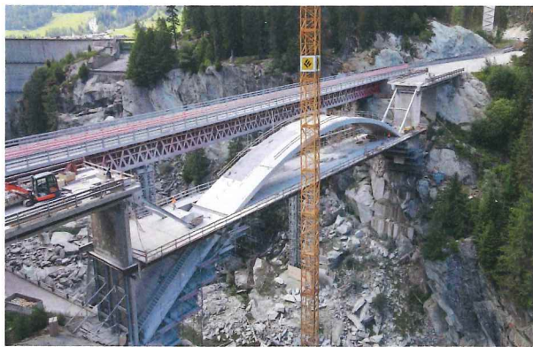
Bauphase 3: Ansicht des Bogens.
