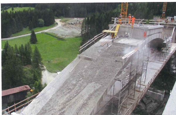
Bauphase 3: Beginn des Hochdruckwasserabtrags auf dem Bogen.
