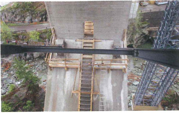
Bauphase 2: Die Verstärkungsdiagonalen führen jeweils vom Kämpferstützenkopf auf den Bogen.
