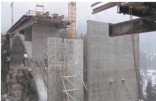
Bauphase 5: Abbruch der Pfeiler der Vorlandbrücke; die Pfeiler und Träger des Bogens sind bereits neu.
