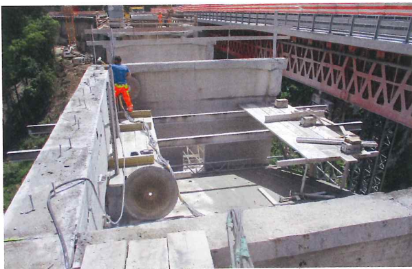
Bauphase 2: Schneiden der Fahrbahnlängsträger.
