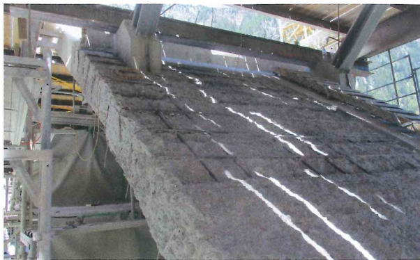
Bauphase 3: Der Hochdruckwasserabtrag am Bogen beträgt 60 mm.
