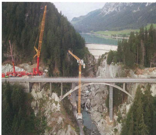
Bauphase 1: Aufbau des 500-t-Autokrans für das Einheben der Rüstbinder. Vorn der Baustellenkran.
