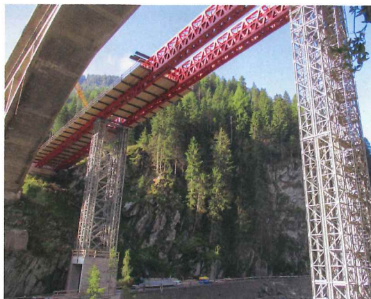
Bauphase 1: die Hilfsbrücke mit dem Arbeitsgerüst für das Betonieren der Fahrbahnplatte. Der Pfeiler fusst auf einer Betonkonstruktion, durch die die Zufahrt zum Kraftwerk führt.
