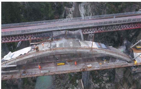
Bauphase 3: Verstärkung des Bogens mittels Überbeton.
